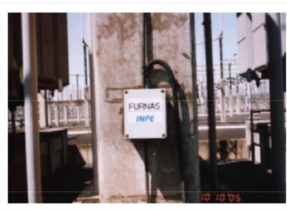
**direta:** magnetômetros instalados no neutro do terra de sistemas de transmissão de energia (medem corrente por efeito Hall)
